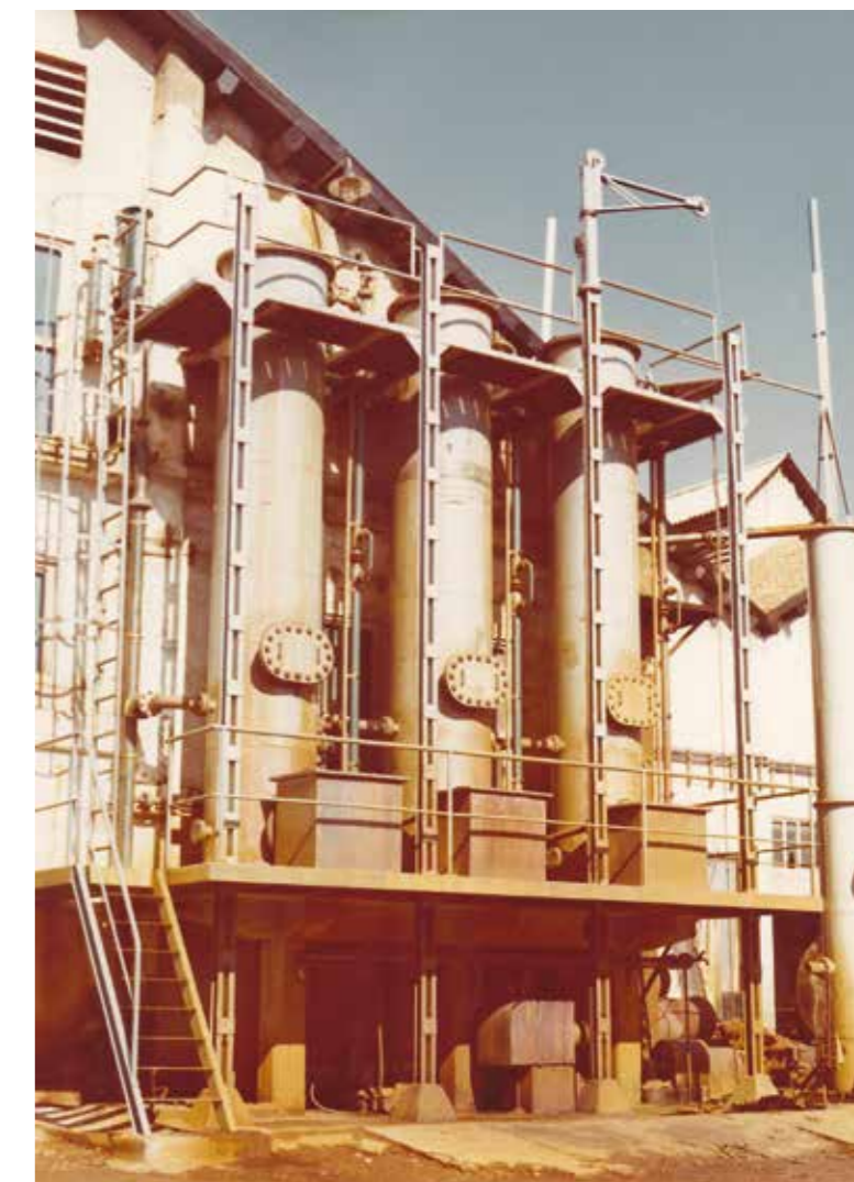
Antigua planta de cloruro férrico.
