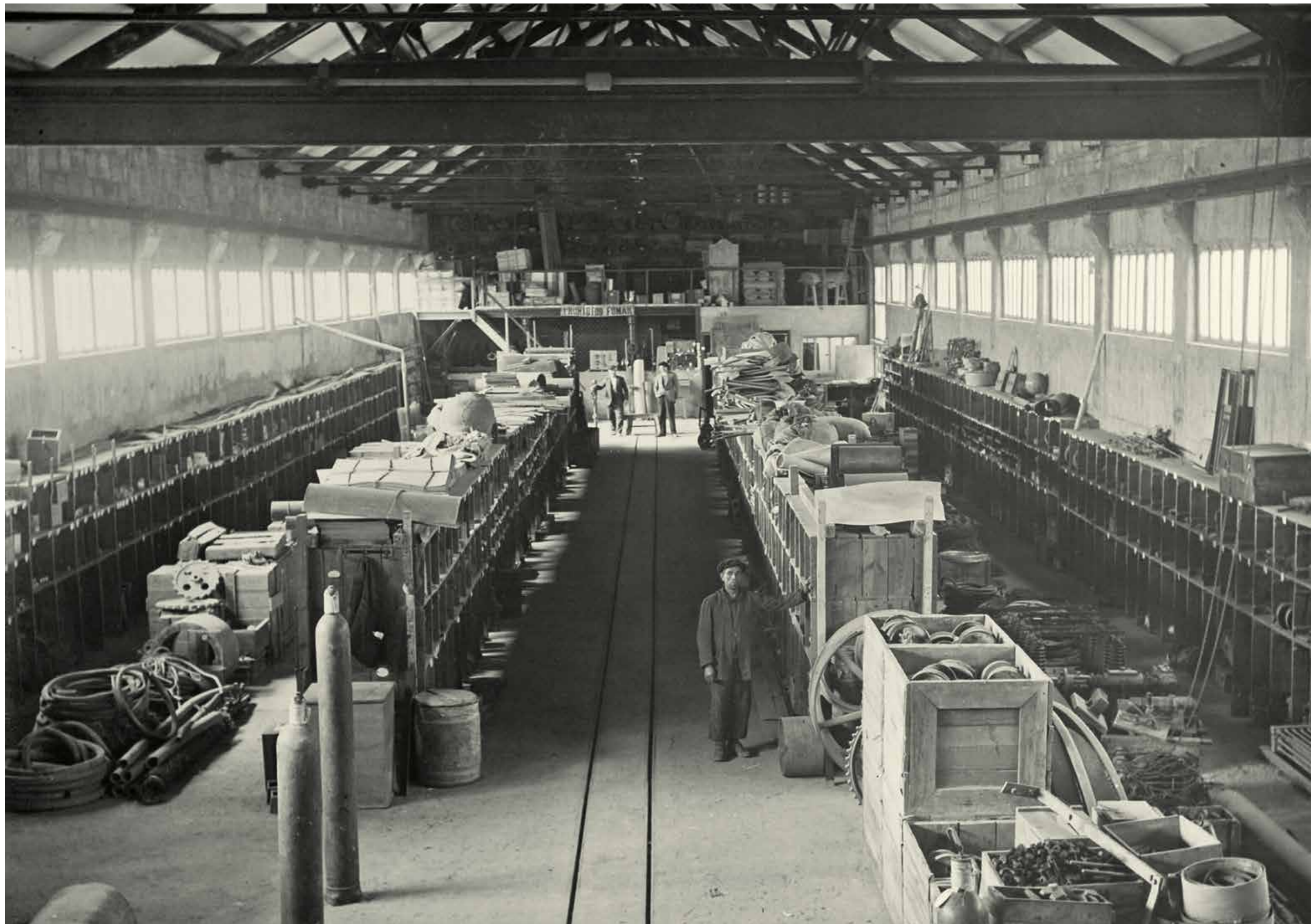
Panorámica del almacén general de la fábrica.
