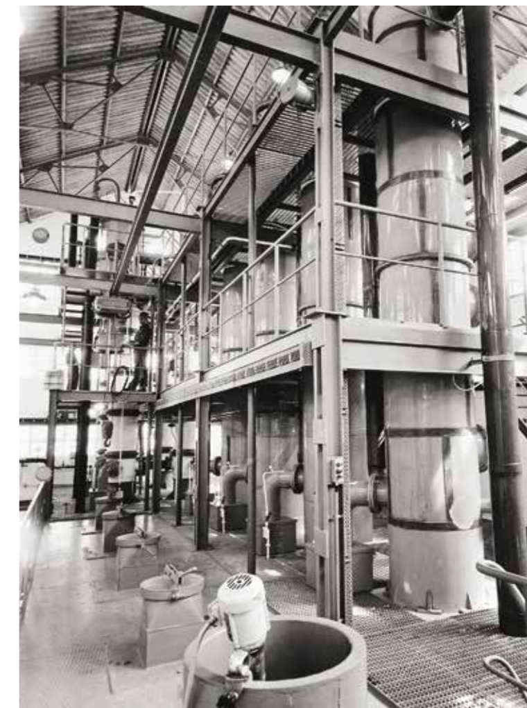
Fabricación de clorito. Torres de absorción de \text{ClO}_2 .
