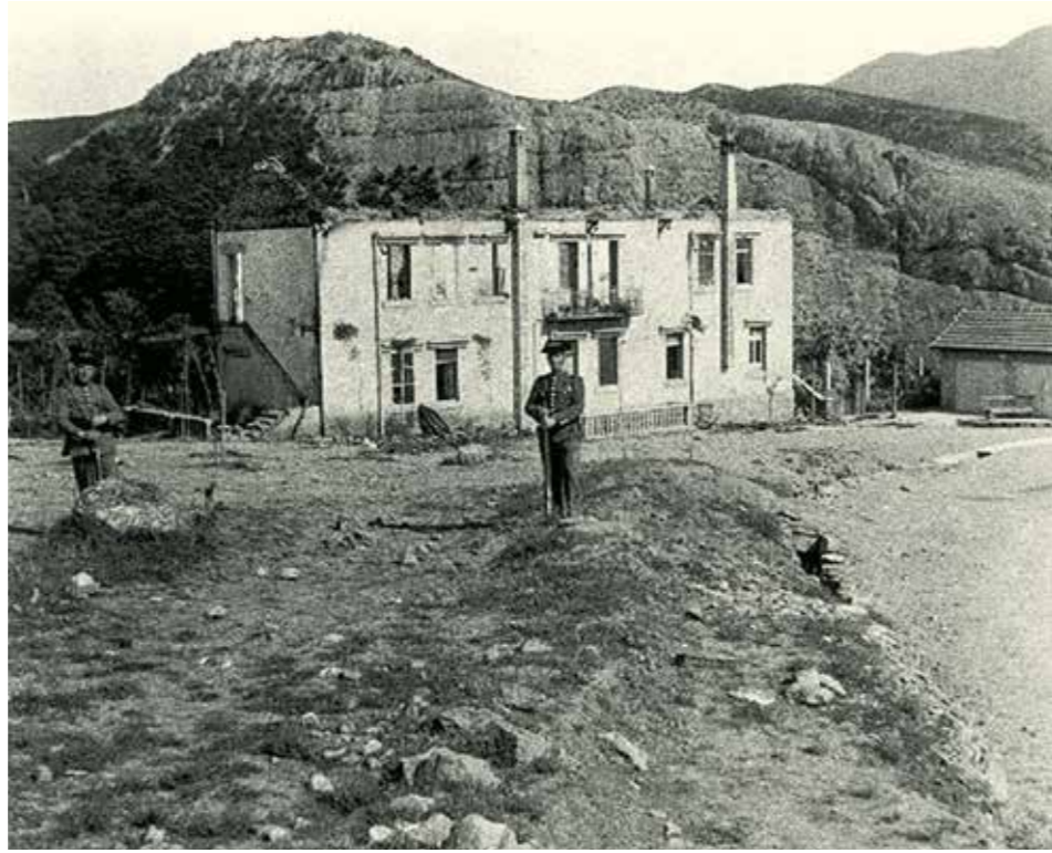
En la imagen se aprecia el estado en el que quedó el chalet de los ingenieros tras el incendio.
