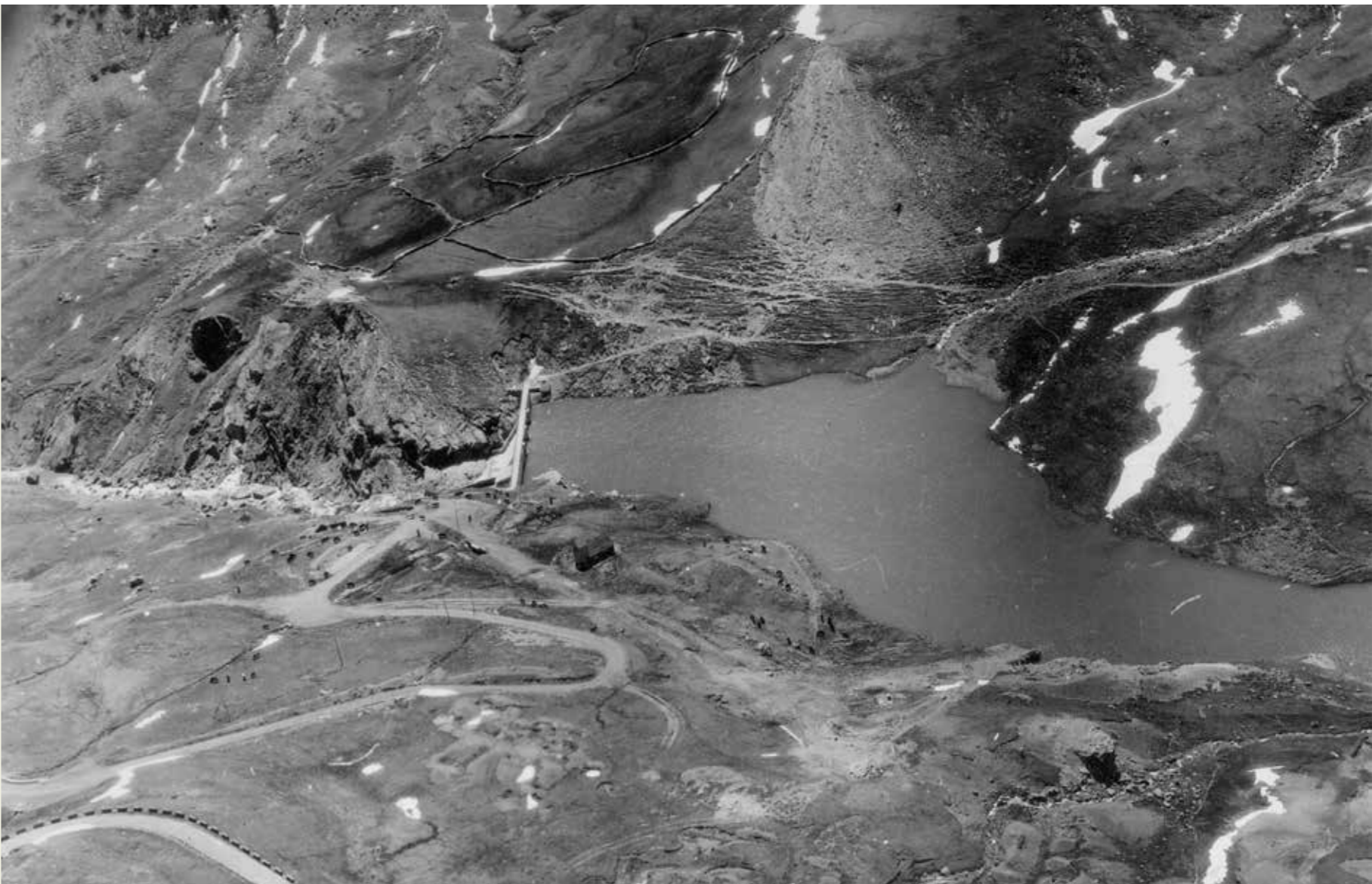
EIA, S.A., encargó entre 1953 y 1955 un reportaje fotográfico aéreo de la fábrica y los aprovechamientos del río Gállego a la empresa TAF Helicopters. Archivo Nacional de Catalunya. Arriba, imagen aérea de la presa de Formigal.
