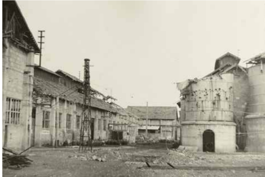
Como se puede apreciar en los edificios sobre estas líneas, la fábrica quedó muy afectada.
