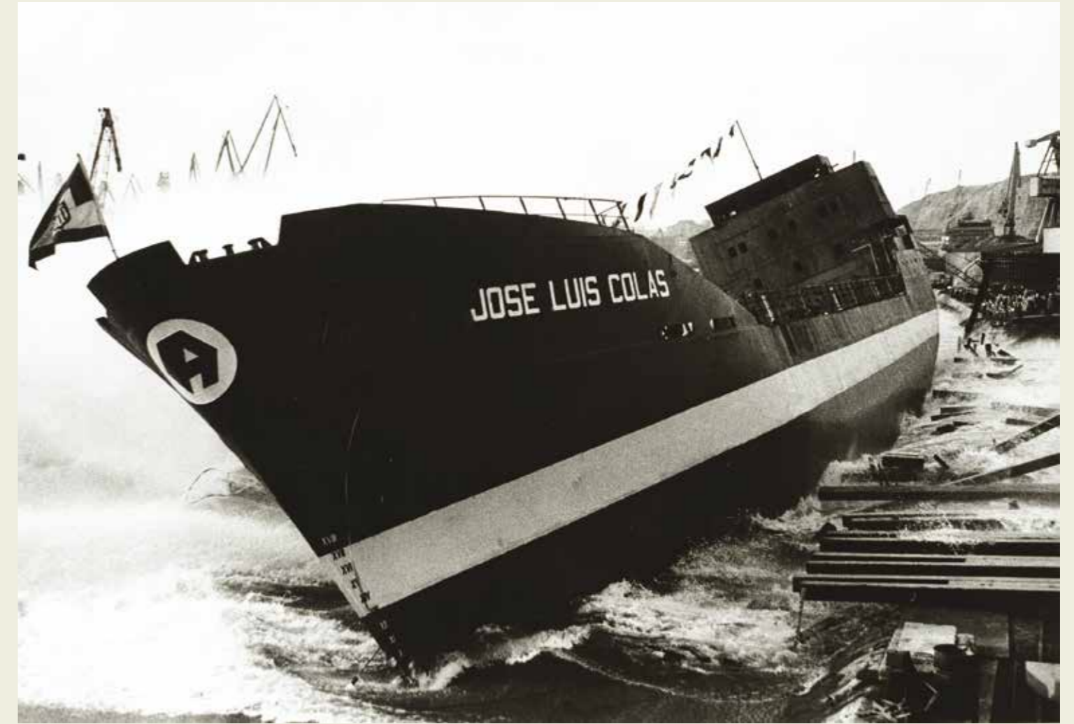
El José Luis Colás se construyó en Bilbao, en la Ría de Nervión. La botadura fue en la modalidad denominada «de costado», como se puede apreciar en la fotografía.
