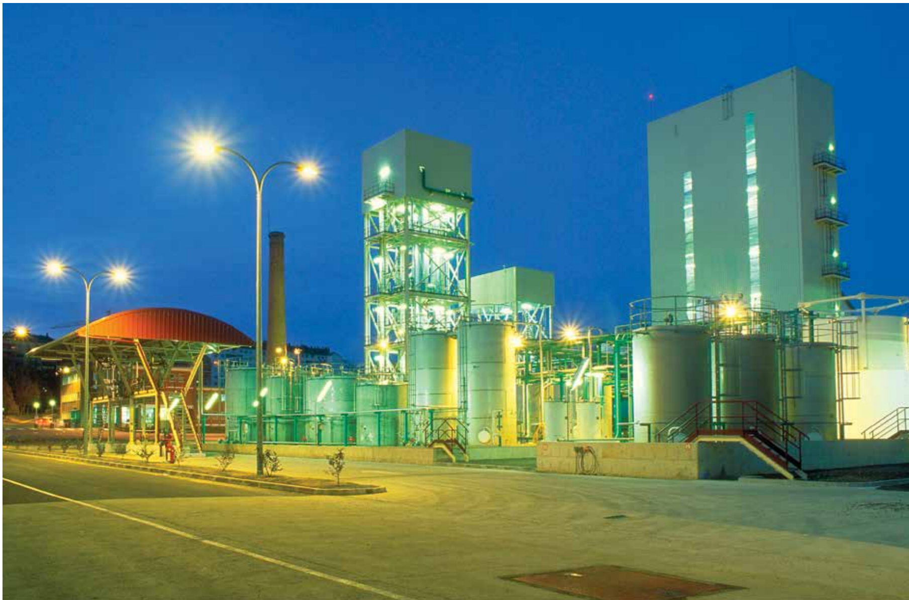
Planta de agua oxigenada. Imágenes de la planta de agua oxigenada en esta página y la siguiente.
