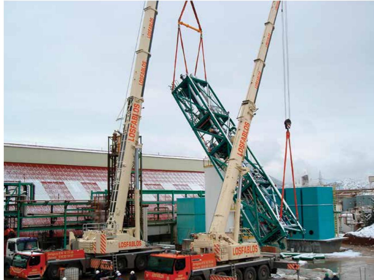
Operación de izado del horno de ácido clorhídrico el 6 de febrero de 2018.
