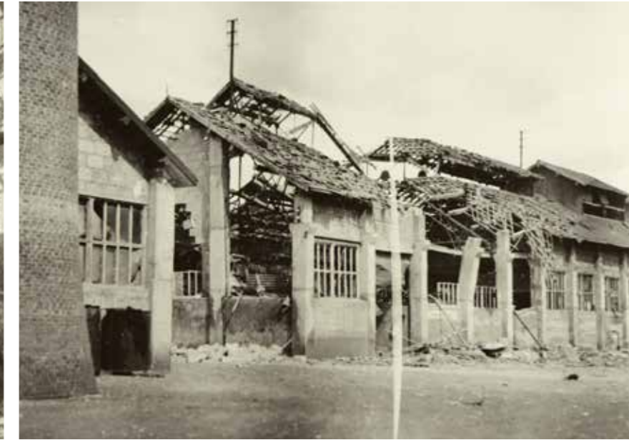
Dos perspectivas del edificio destinado a la fabricación de cloratos, prácticamente destruido en los bombardeos del 11 de mayo de 1937. Fachadas norte y sur.
