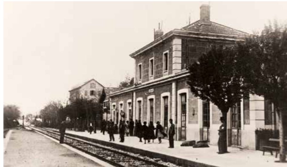
Estación de Sabiñánigo.
