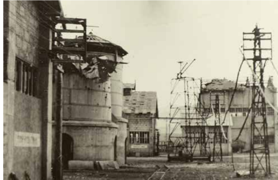
Instalaciones para la fabricación de nitrógeno y estado de la central transformadora tras los bombardeos.
