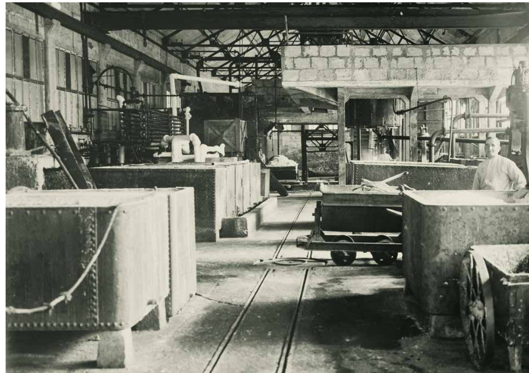
Taller de construcción de cubas para la fabricación de clorato que comenzó a funcionar en 1927.
