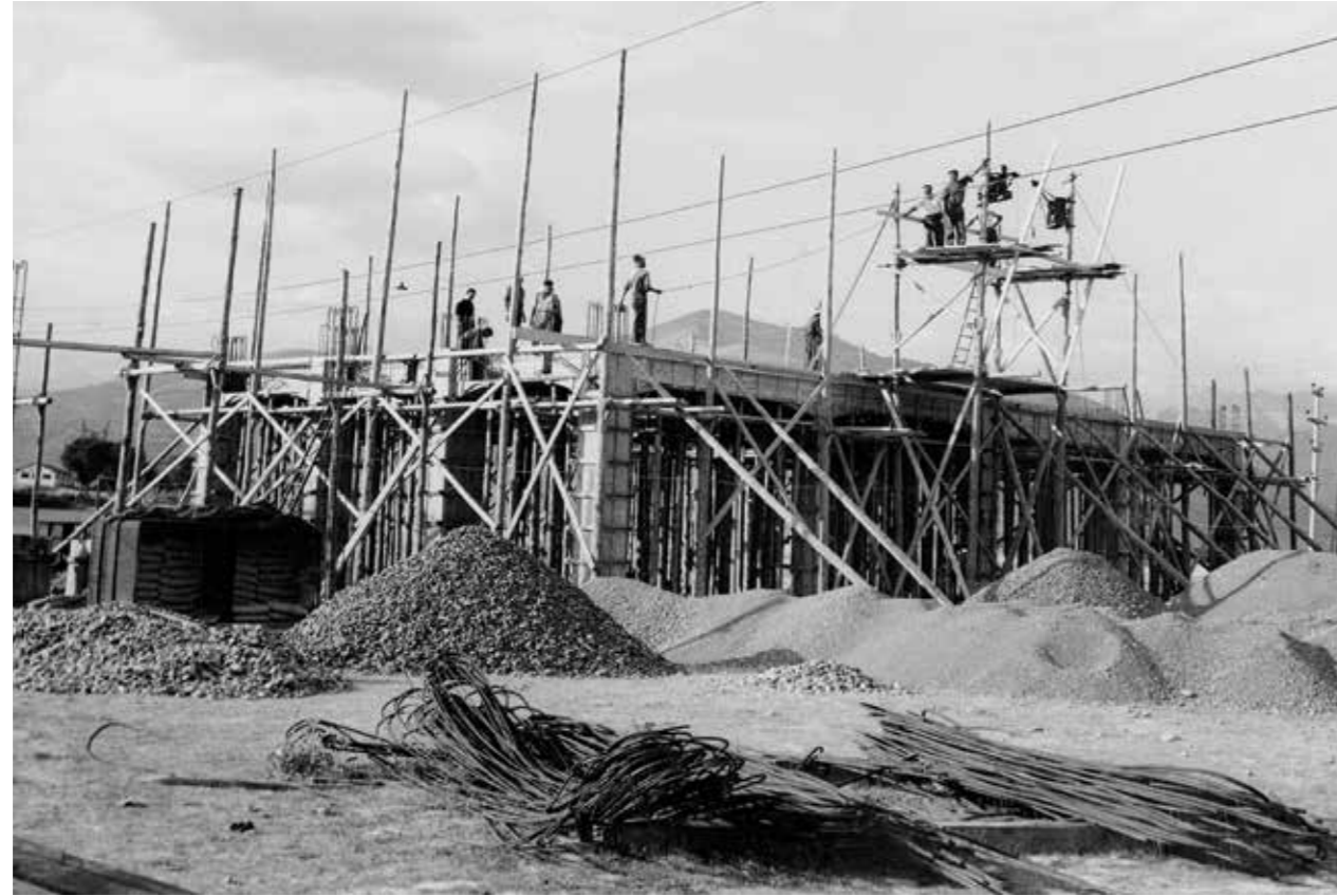
Secuencia de la construcción de la sala I de Dequisa.
