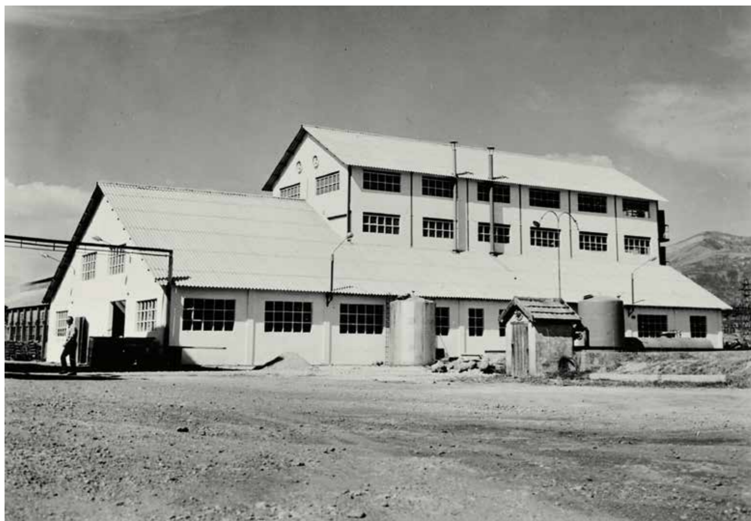
Instalación para la fabricación de clorito.
