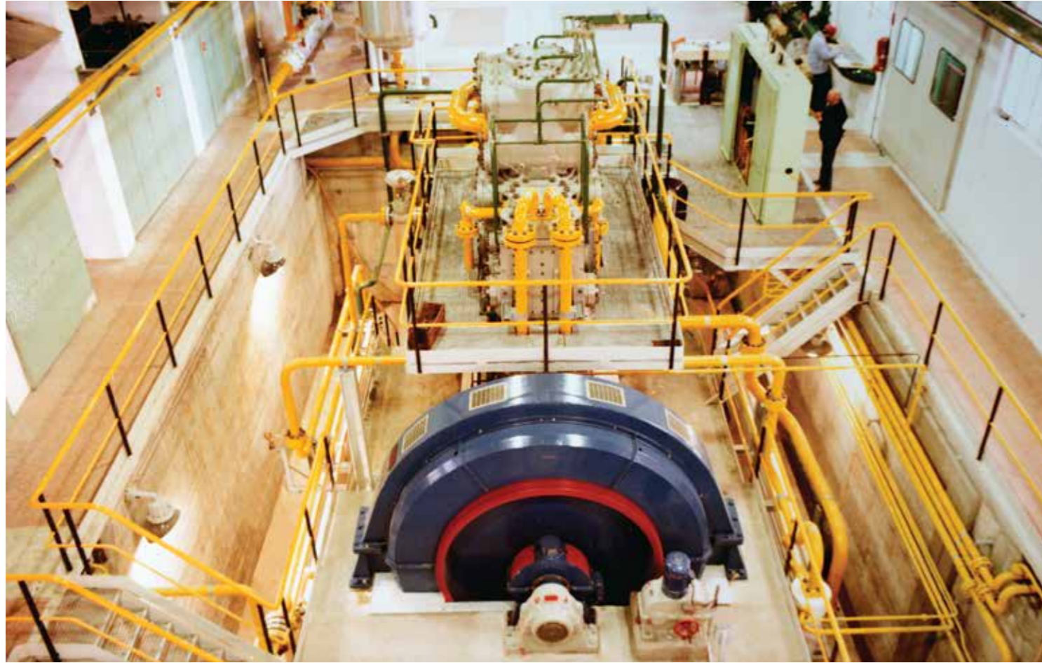
Instalaciones actuales para la fabricación de amoníaco.
