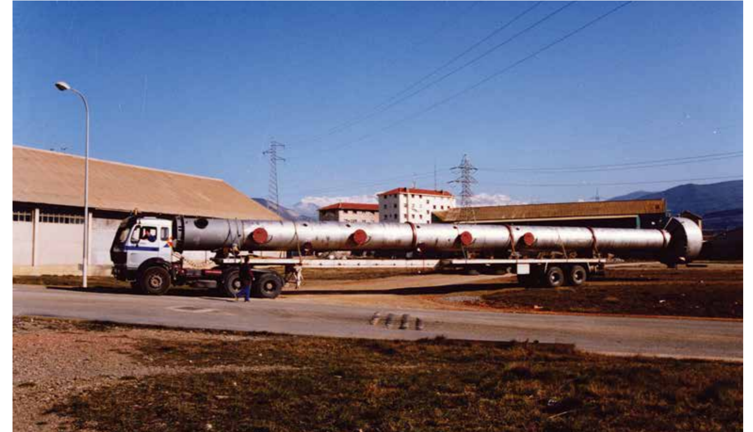
En página anterior, montaje de la planta de agua oxigenada. Arriba, traslado de la columna de absorción de oxígeno.
