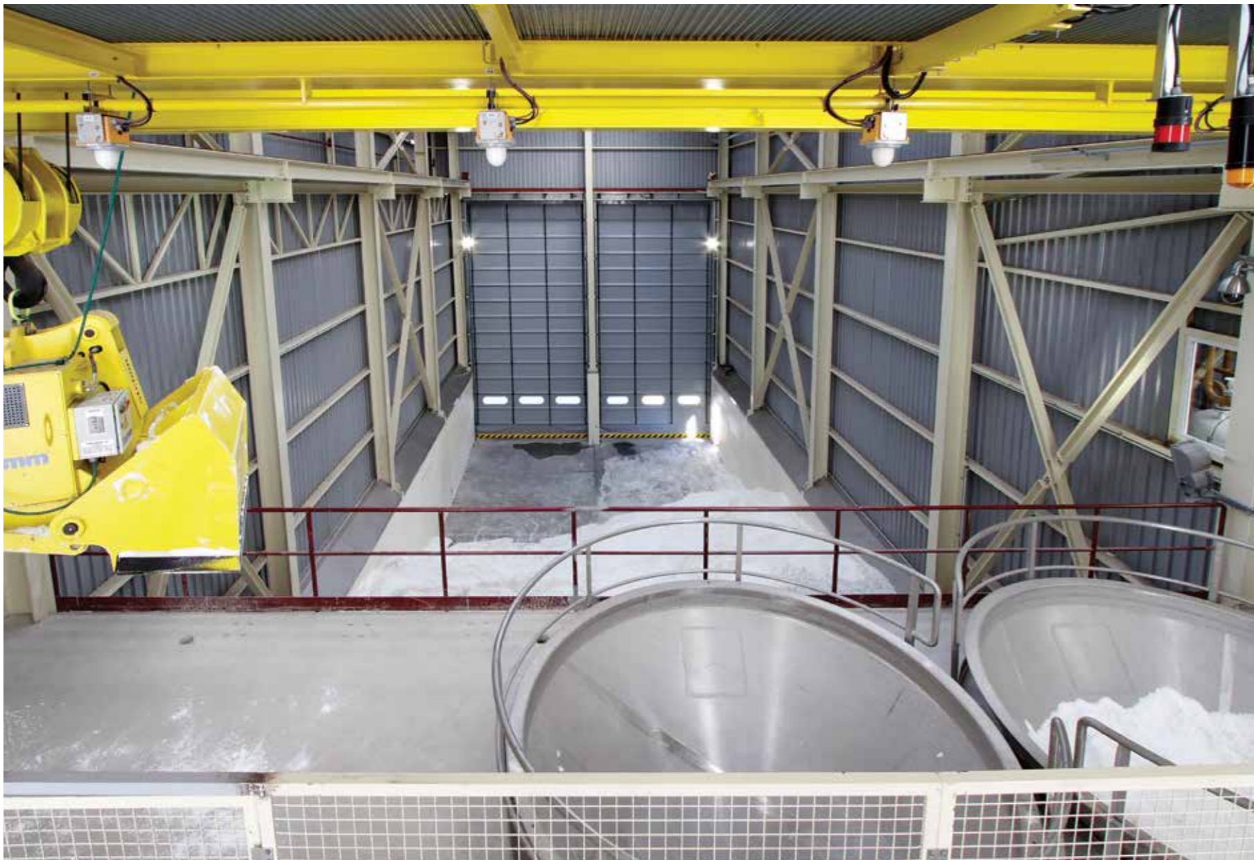
Almacén de sal y alimentación a los saturadores de cloro sosa.
